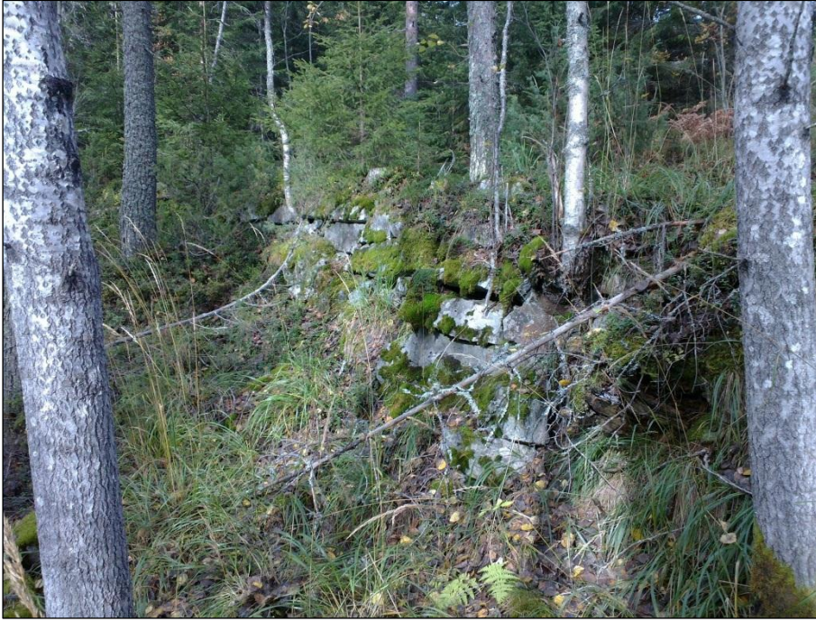
Kivettyä tien pengertä rinteessä. Kuvattu pohjoiseen.
